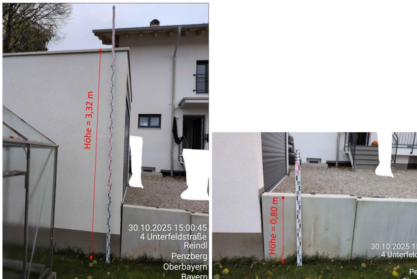
Grenzgarage im Nordosten
