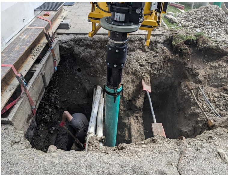
Saugbagger Einsatz zum schonenden Aushub.
